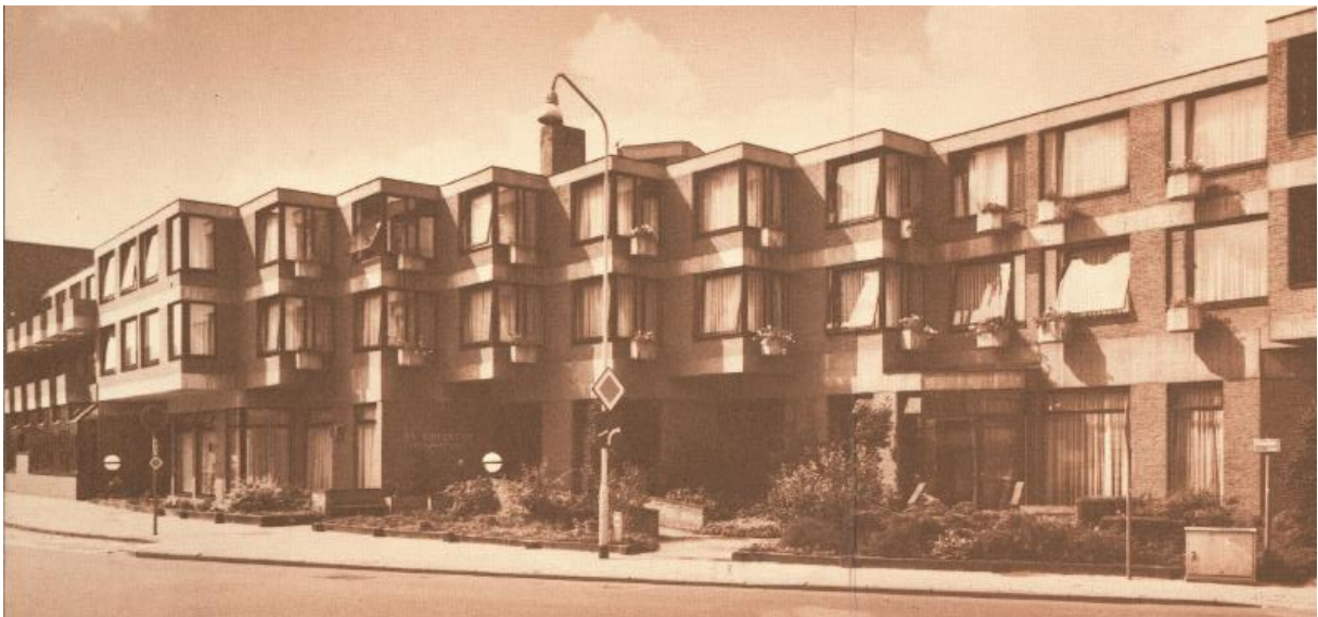
Voor- en achterzijde van het nieuwe gebouw bij de opening in 1980
